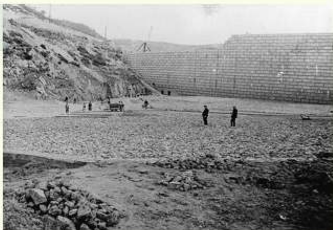
Treballs de impermeabilització del llit del Pantà de Foix a caus de la rierada de 1913.
